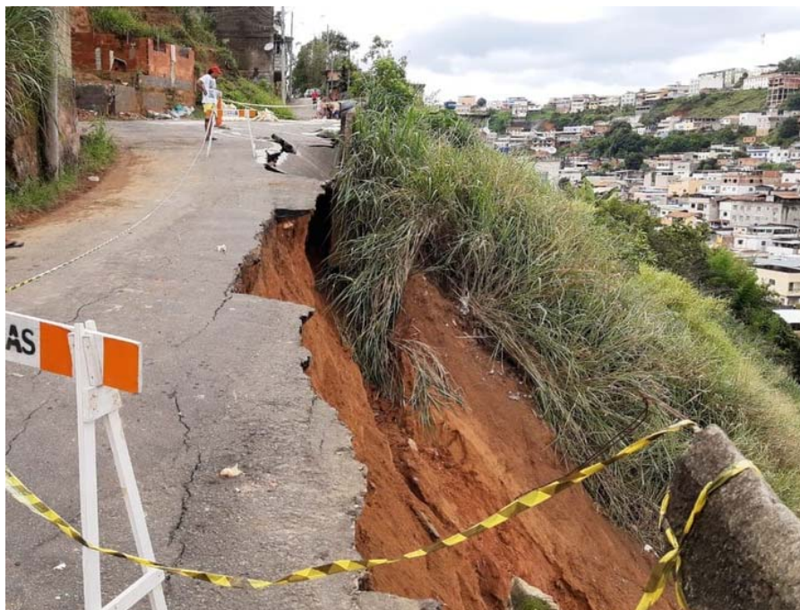
Figura 04 – Imagem do local, logo após ao escorregamento do talude na rua José Orozimbo de Oliveira. Fonte: G1 - 2020
